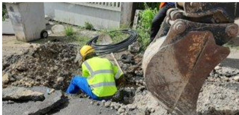
Photo : Réparation d'une fuite
